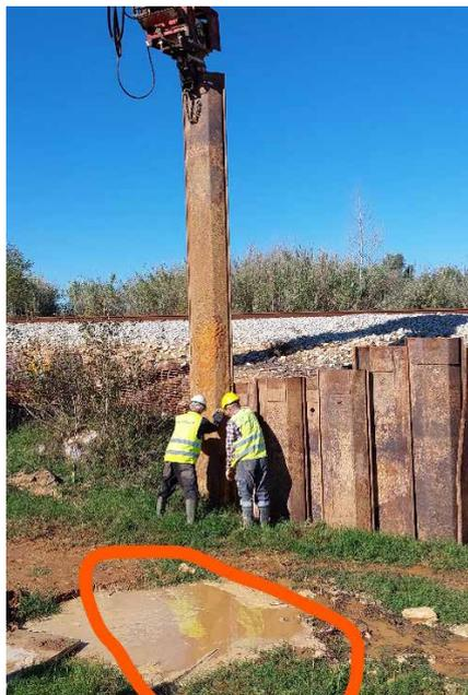
Exemplo de uma reparação de rotura em conduta – fuga no ramal que abastece as ilhas da Armona e Culatra.
