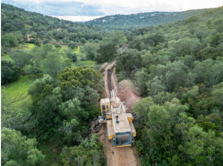
*Figura 1 - Fases de Reforço de Adução a Loulé - Fase III – Escavação de vala para instalação de conduta.*
