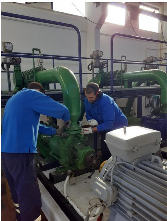
Manutenção de Grupo Eletrobomba na Estação Elevatória
