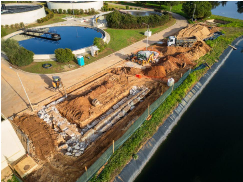
*Figura 2 - Execução de Infraestruturas de Elevação e Adução ApR – ETAR de Vilamoura (PRR) – trabalhos de movimentação de terras.*
