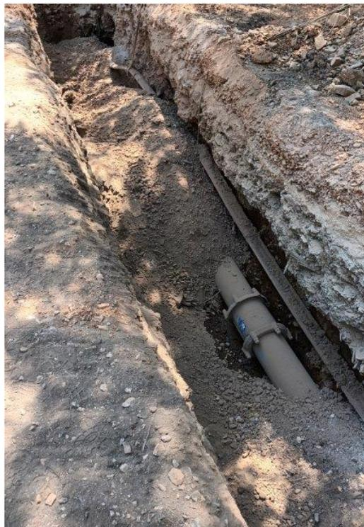
Reparação de rotura em conduta FFD DN250
