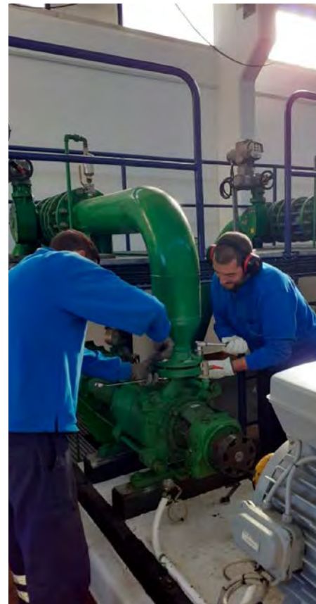
Manutenção de Grupo Eletrobomba na Estação Elevatória para S. Brás de Alportel.
