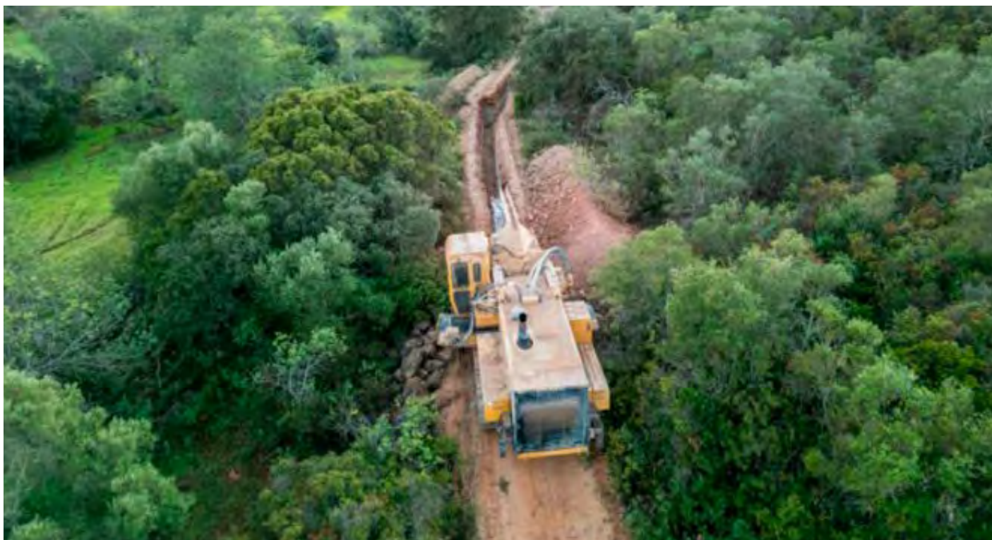
Figura 1 - Fases de Reforço de Adução a Loulé - Fase III – Escavação de vala para instalação de conduta
