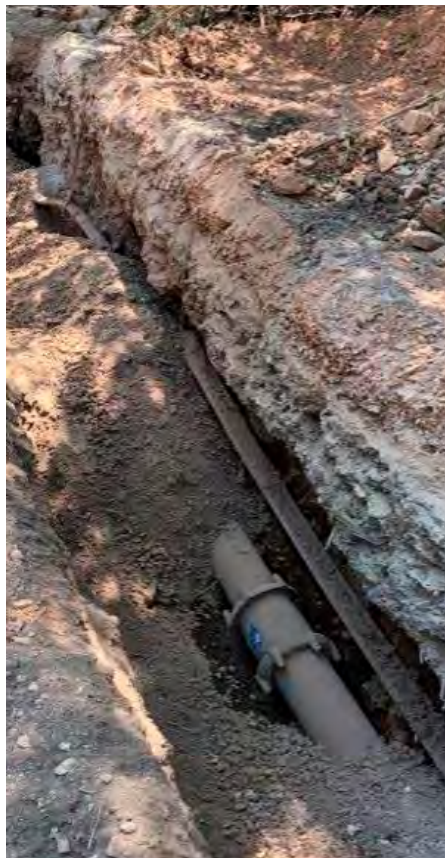
Reparação de rotura em conduta FFD DN250 no ramal para Monchique.
