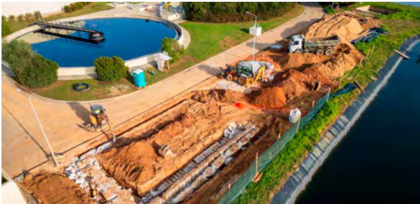
Figura 2 - Execução de Infraestruturas de Elevação e Adução ApR – ETAR de Vilamoura (PRR) – trabalhos de movimentação de terras.
