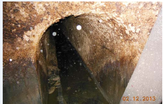
Túnel de Portimão
