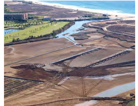
Obras de construção civil (movimentos de terras, órgãos de betão armado, circuitos hidráulicos, etc.), aprofundamento de valas, escavação de fundões para a execução de aterros para a construção de ilhotas e dique
