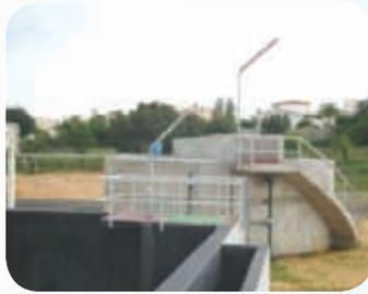
Desidratação de lamas através de centrifugação e armazenamento de lamas desidratadas em silo.
