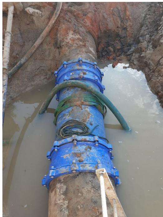
Reparação de fuga em conduta de Fibrocimento DN600, com acesso dificultado pela proximidade do talude de viaduto rodoviário e com a ribeira da
