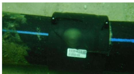
Reparação de fuga em conduta de PEAD DNI 60 localizada na travessia entre as Ilhas da Armonia e da Culatra, em zona permanentemente submersa.
