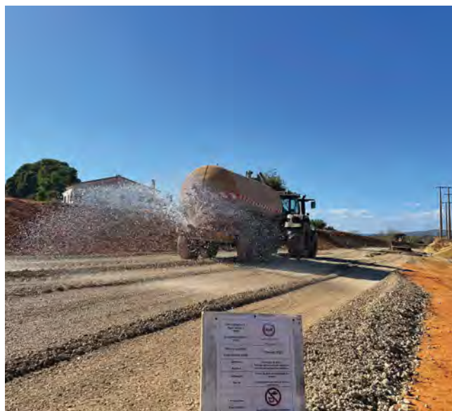
Figura 9 – Uso de ApR para humedificação de vias numa das Frentes de Obra da EN125 – Variante a Olhão
