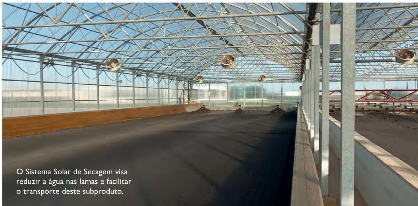
O Sistema Solar de Secagem visa reduzir a água nas lamas e facilitar o transporte deste subproduto.
