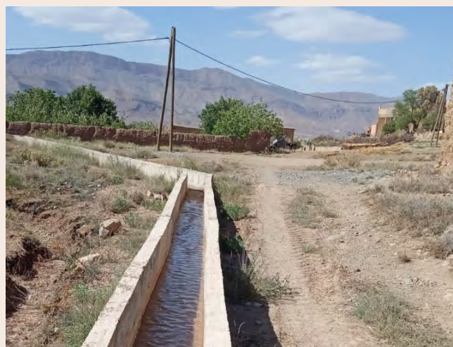
Novo canal principal à esquerda do antigo (não betonado)
