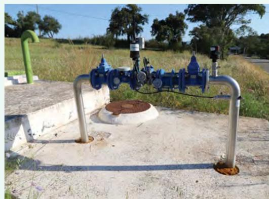
previu também a montagem de contadores ultrassónicos e *dataloggers* em todos os pontos de monitorização, assim como a instalação de *software* de análise, monitorização e alarme.
