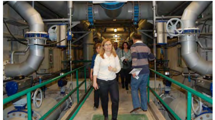
Visita à ETA de Alcantarilha - galeria de filtros da ETA de Alcantarilha - com Eng o Helena Lucas da AdA
