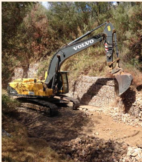
Trabalhos já iniciados
