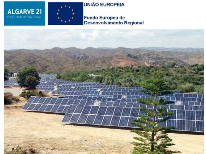
Vista parcial da instalação de painéis fotovoltaicos na ETA de Tavira
