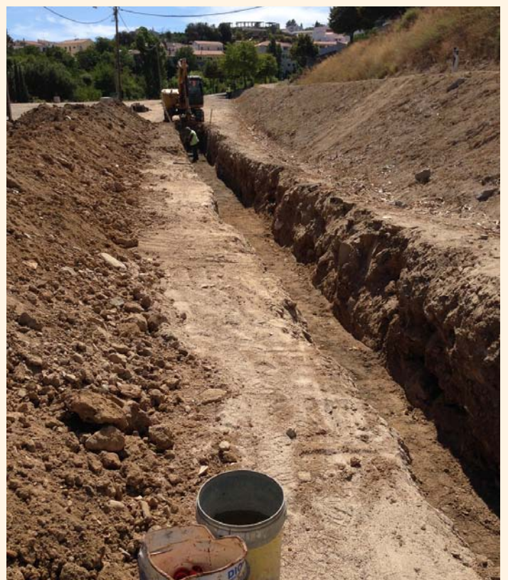
Trabalhos já iniciados
